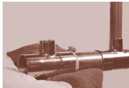
Figure 8. Remoción del exceso de fundente
